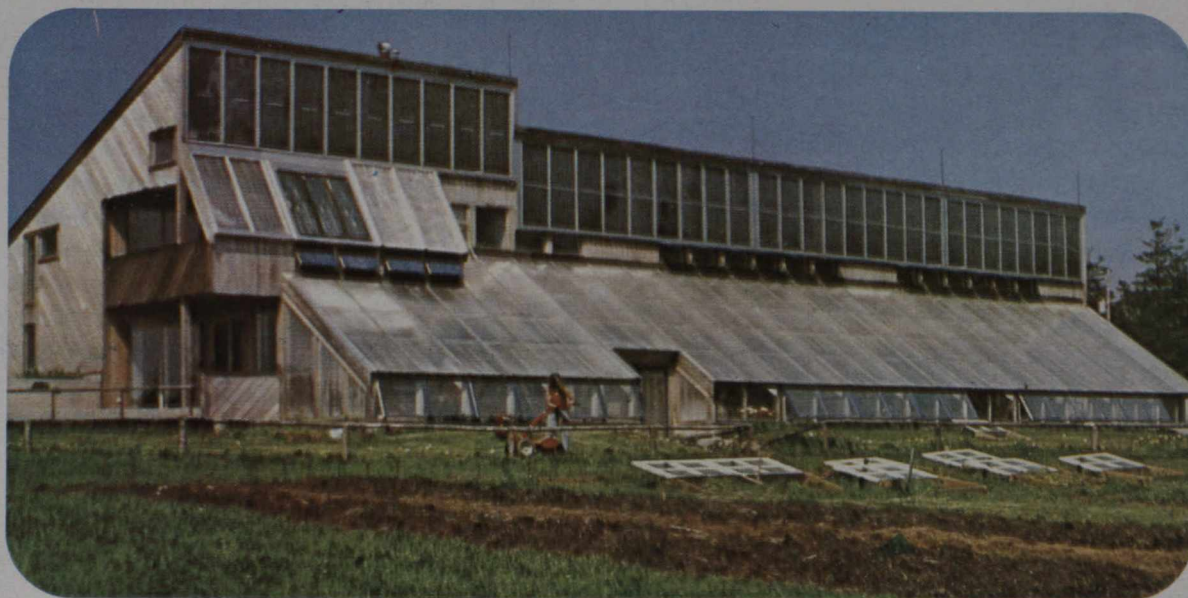
El "arca" es un sistema diseñado para producir calefacción, alimentos para el autoconsumo y agua potable dentro de un marco ecológico balanceado para la habitación humana
