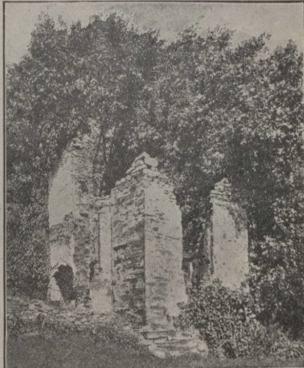
Le Canada pittoresque. — Les ruines du vieux fort Senneville, actuellement dans la propriété Clouston.
