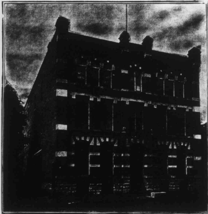
W. H. GILLARD & CO'S WAREHOUSE, Hamilton.
