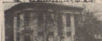
▲ CARRALL & HASTINGS 商業樓宇。四租客。三層及另一樓宇。月入 $3400。開價 $650,000 梁寶琴 688-7888 潘錦明
