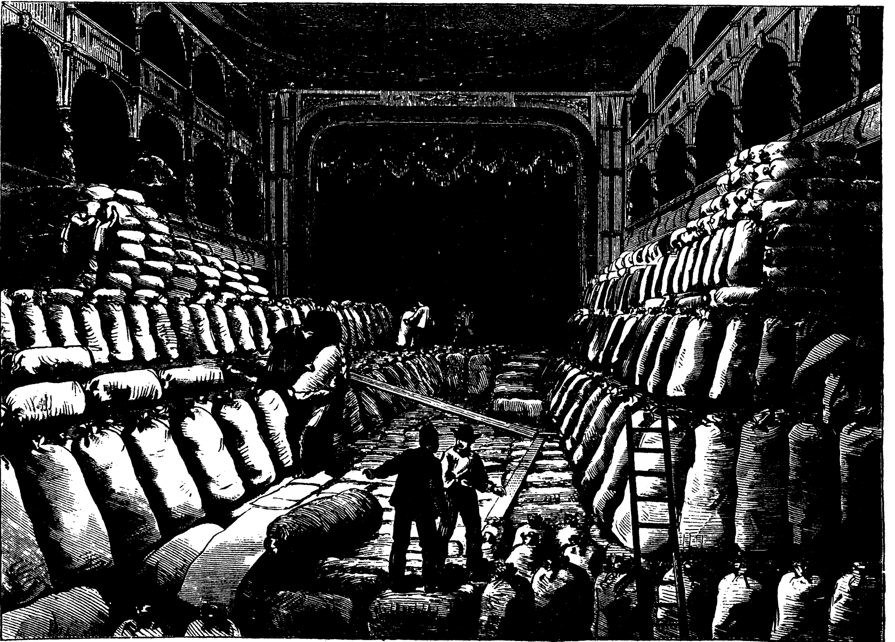
EMMAGASINAGE DE PROVISIONS DANS LE CASINO DES ARTS, À LYONS.
