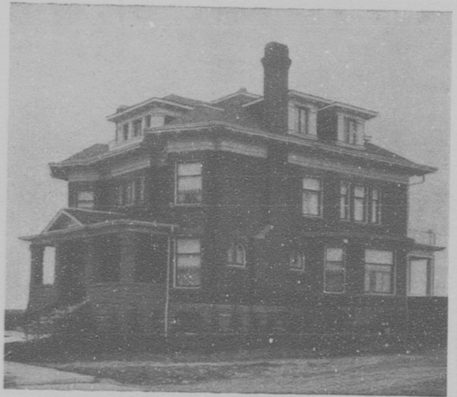
Residence of O. S. Chapin.
