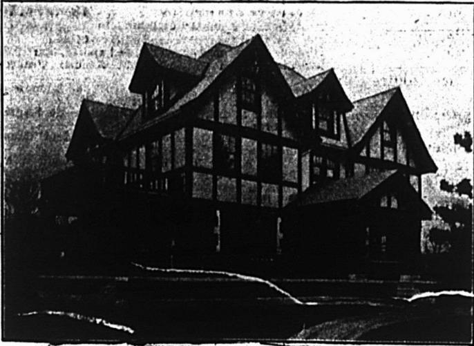
Notre gravure représente une maison d'habitation couverte en Bardeaux en Ciment Asbeste et revêtue sur les côtés de notre Bois de Construction à l'Asbeste. Ces deux matériaux sont absolument à l'épreuve du feu et résistent aux intempéries sans subir la moindre détérioration. Ils n'exigent ni peinture, ni vernis et conservent en tout temps une belle apparence.
