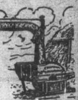
Souffleur à paille, s'adapte à toutes les batteuses en usage soit à toile ou à fourches, etc. Ce souffleur peut retenir la balle ou l'expulser avec la paille. Avec toile pour la balle pour batteuses à fourches ou à baquettes.
