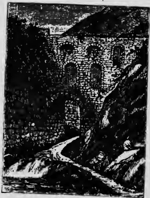
Fig. 38.—Canal en maçonnerie sur le Rodadero
