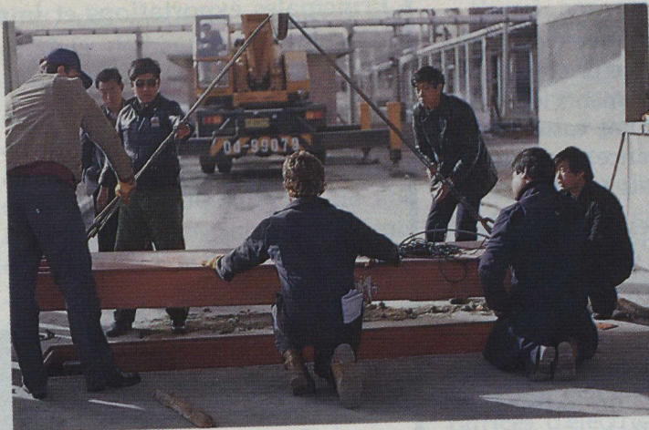
Des techniciens de la Canadian Scale Company Ltd. de Toronto, s'affairent au montage d'un système entièrement électronique d'une balance de camion en marche dans une installation de manutention de charbon à Taiyuan, en République populaire de Chine. C'est le premier du genre dans ce pays.
