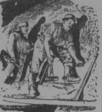
Der Eingang im Abbau.
