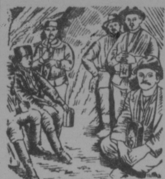
Vor Beginn der Arbeit.
