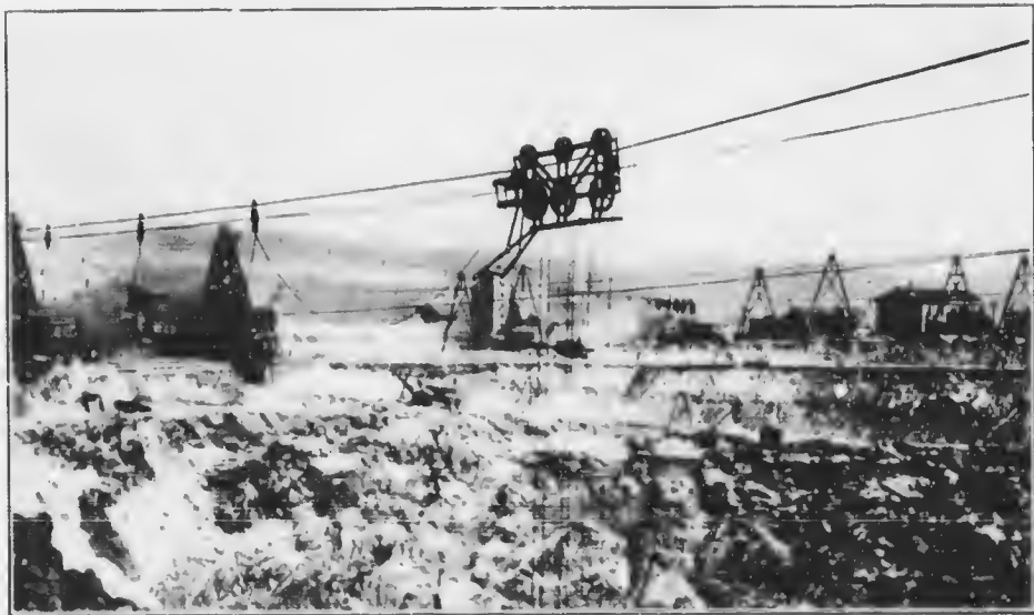
Fig. 17.—Carrière d'amiante King. Câbles et chariot de câble-grue.
