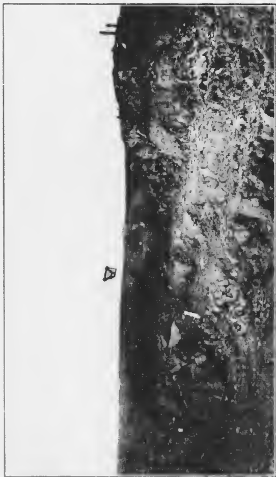
Fig. 13. — Mine Jeffrey, à Dauville, montrant exploitation par gradins.
