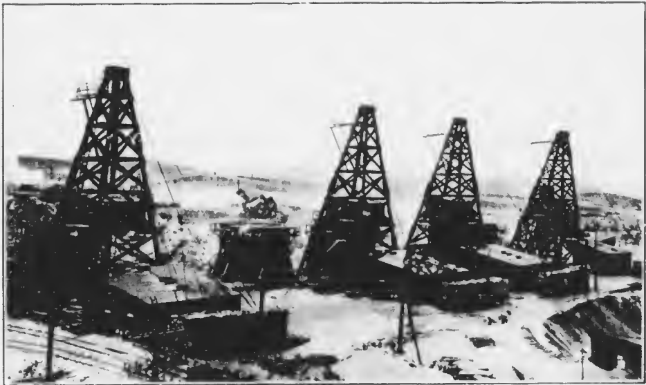
Fig. 16.—Carrière d'amiante King, Thetford. Pylônes des câbles-grues.
