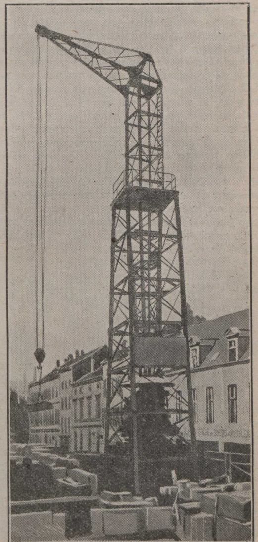
Nouvelle grue électrique, allemande, montée sur tour
