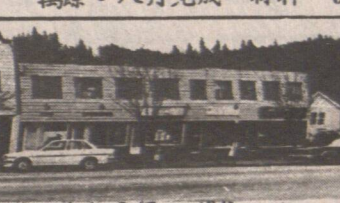
▲全新屋在建中·近 KINGS WAY 同 SLOCAN·叫價十八 萬餘·八月完成·材料一流
