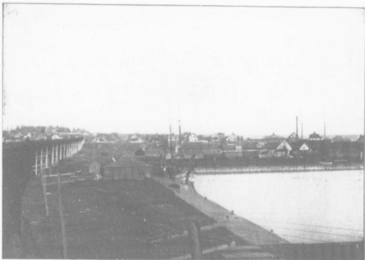
G. T. R. VIADUCT AND HARBOR
