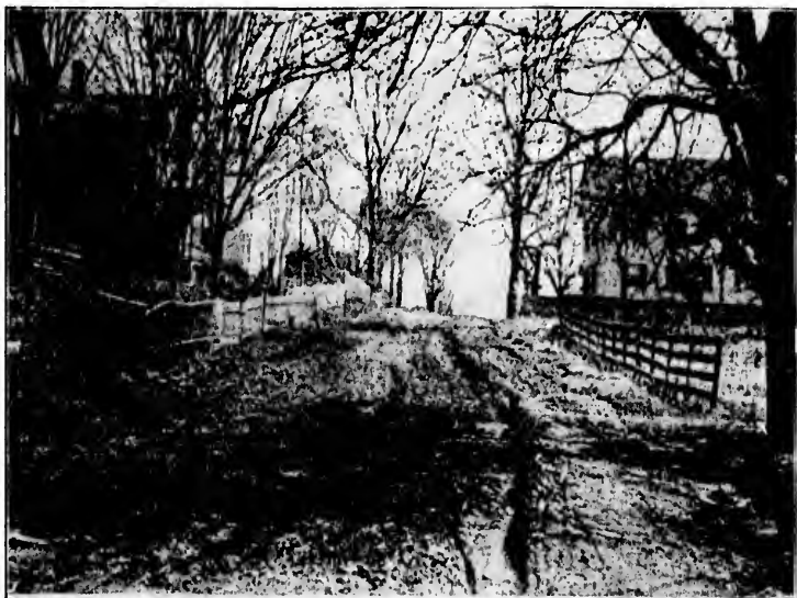
Fig. 5.—CHEMIN MAL ENTRETENU ET SANS FOSSÉS.
