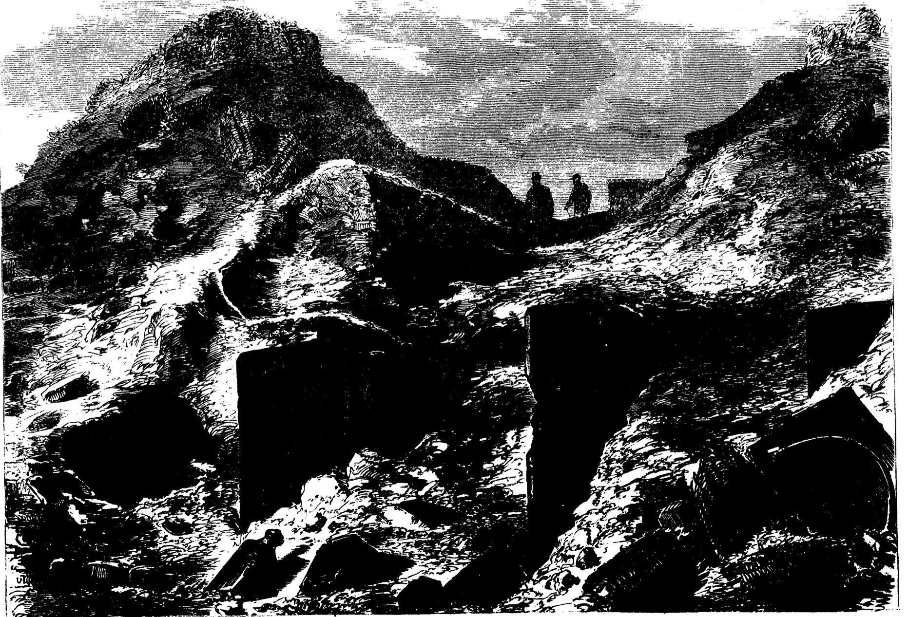
PARIS.—PARTIE DU MUR D'ENCEINTE.
