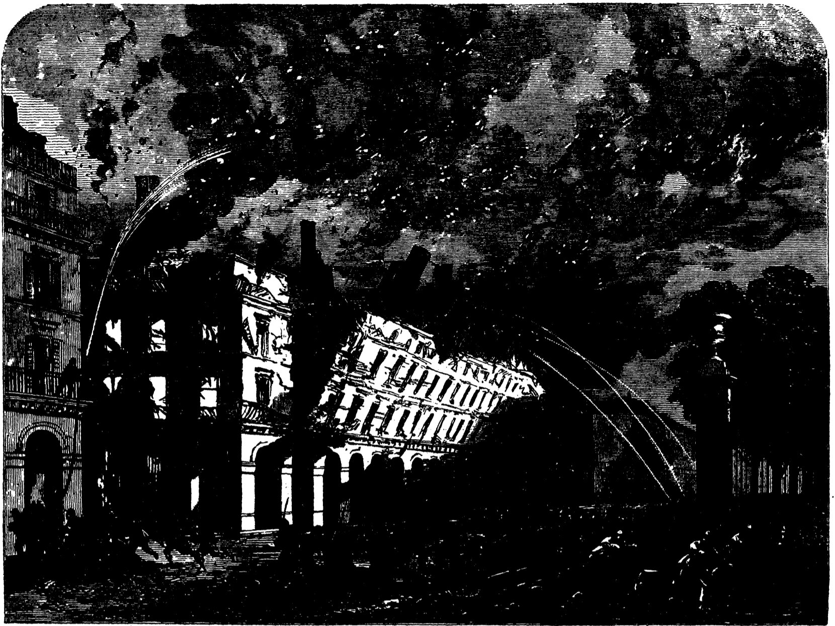
INCENDIE DE PARIS.—ÉCROULEMENT DE MAISONS DANS LA RUE DE RIVOLI.
