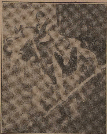
Travaux en plein air.
