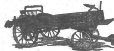
C'est l'épandeur léger le plus pratique qui soit offert en vente. Il possède un deuxième cylindre distributeur et pulvérisateur d'engrais. Épand 4 à 30 voyages à l'arpent. Facilement tiré par deux petits chevaux. L'essieu d'avant est court empêchant le timon de frapper les chevaux. Garantie de 5 ans.
