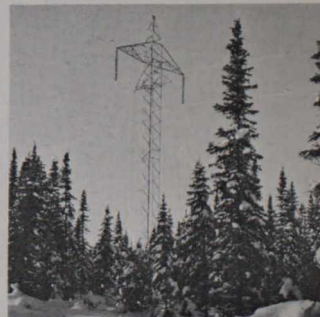
4 114 pylônes de 52 mètres de haut
