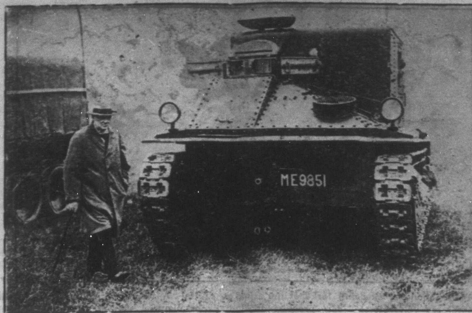
Az angol hadsereg legújabb acélszörnyetege a két gépfegyverrel és egy kis ágyúval felszerelt gyors-tank, mely még térdigérő sárban és hepehupás terepen is nagy sebességgel halad. A "Southam Newspaper Syndicate" szíveskedéséből.
