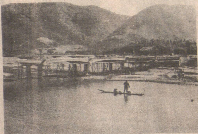
橫跨浙江連接溪口鎮大街寬七米，長一百十米的新型大橋正在建造中
