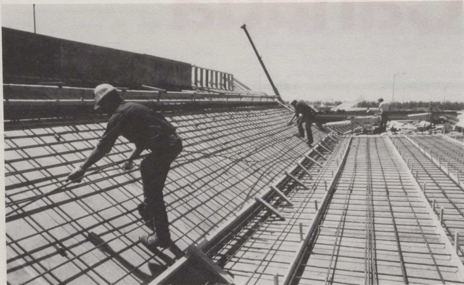
Mise en place de ronds d'armature pour la construction de ponts le long des autoroutes 401, 410 et 403 en Ontario.
