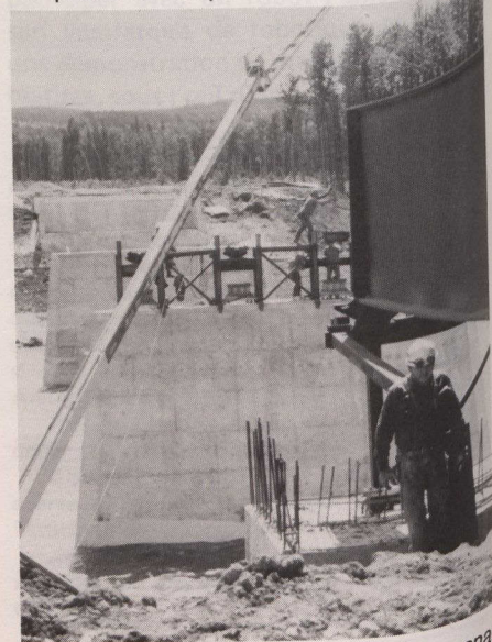
Travaux de construction sur la transcanadienne près de Brooks (Alberta).
