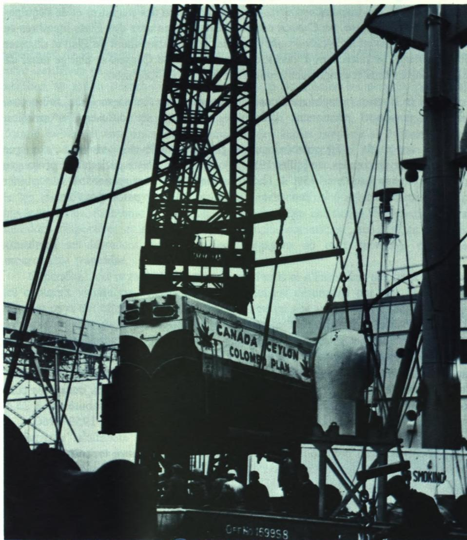
*Ponton-grue embarquant une locomotive envoyée à Ceylan par le Canada, dans le cadre du Plan de Colombo.*
