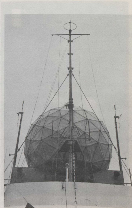
Der Radarschirm ist ein typisches Merkmal des Wetterschiffs "Quadra", welches mit der wohl stärksten Regensuchanlage der Welt ausgerüstet ist.
