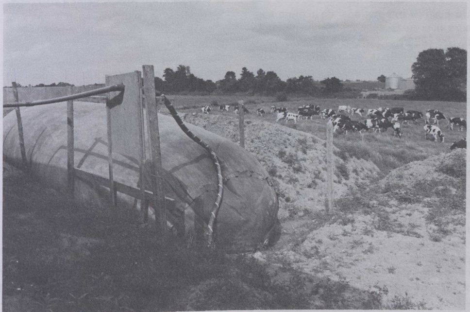
Derrière l'immense ballon de 30 000 litres dans lequel s'accumule le biogaz produit à partir du fumier, un des troupeaux des fermes Gasser pâit. Les fermes Gasser sont une entreprise agricole formée en 1951 par un Suisse établi à Pike River, M. Ernest Gasser.
