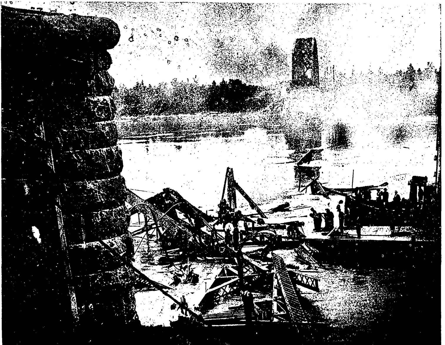
LA CATASTROPHE DE CORNWALL. — LE PONT APRÈS L'ACCIDENT.
