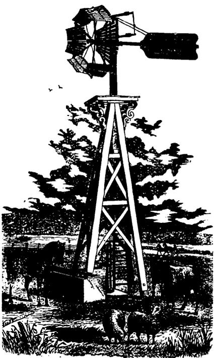
MOULIN A VENT AUTOMATIQUE D'HALLADY POUR POMPER L'EAU SUR LES FERMES, SUR LES CHEMINS DE FER, ETC.
