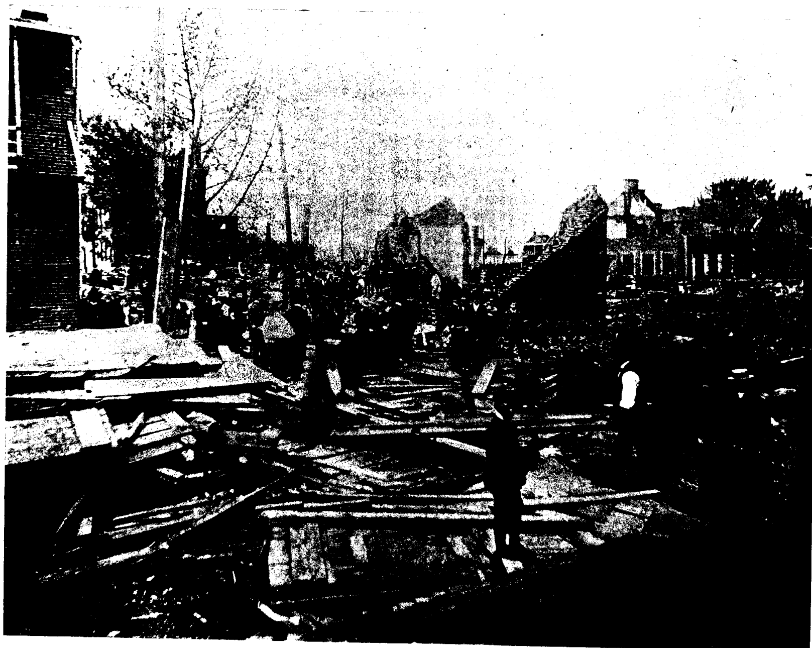
QUEBEC.—Incendie du Quartier Saint-Roch, Boulevard Langelier
