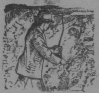
Arbeiten der Rändschürer.
