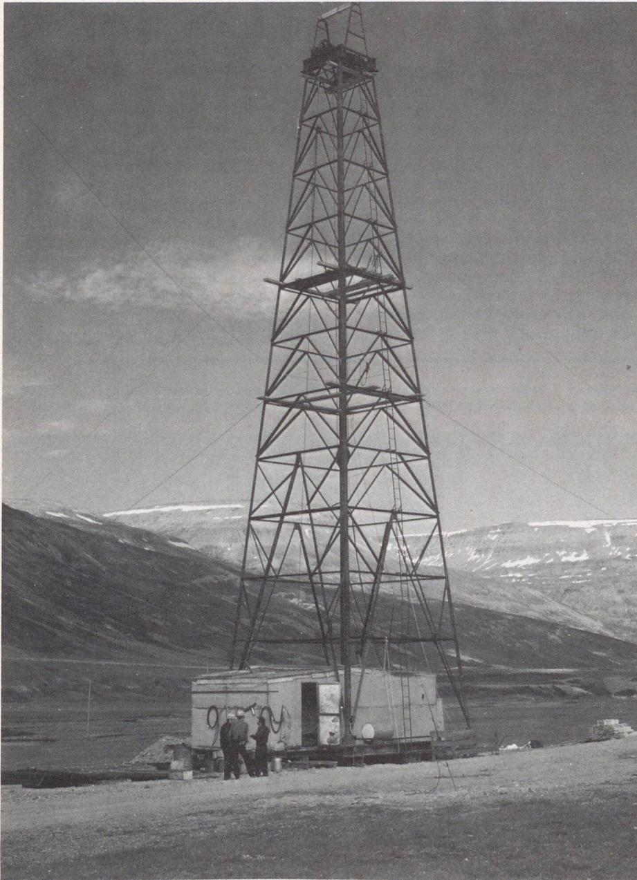
À défaut de pétrole, cet atelier de forage situé en Islande a ramené des échantillons rocheux qui illustrent le mécanisme de la dérive des continents.
