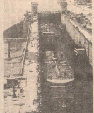
二號船閘。船閘室長 280 米，每次過船需要五十分鐘。圖爲上水船過閘。
