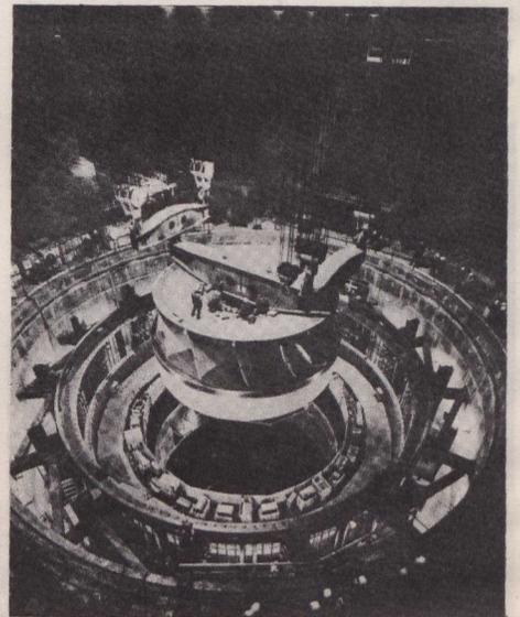
Pour avoir une idée de ses dimensions, il suffit de dire que le diamètre d'entrée est de 11,5m, que le caisson en spirales a une largeur de 33,3m, qu'il contient un million de gallons d'eau, que l'arbre a environ 3m de diamètre, que la couronne pèse à elle seule près de 500 000 kg.
