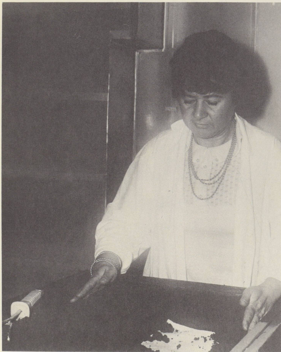
Mlle Georgette Colin, technicienne de laboratoire, place un échantillon d'étoffe traité avec un fongicide dans un plateau contenant un sol à forte proportion microbienne. Le flou de la photo est dû à une humidité de 100% dans une atmosphère à 95°.
