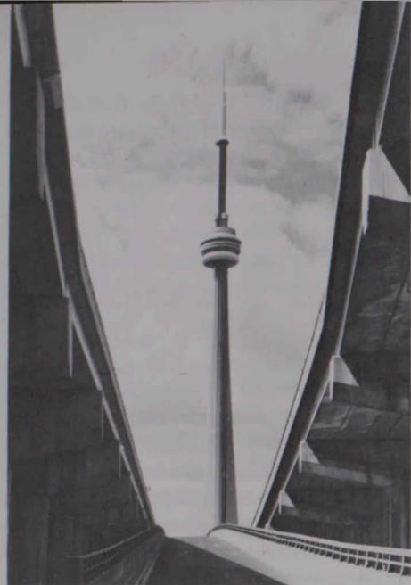
De 545 m. hoge Canadian National telecommunicatietoren in Toronto.
