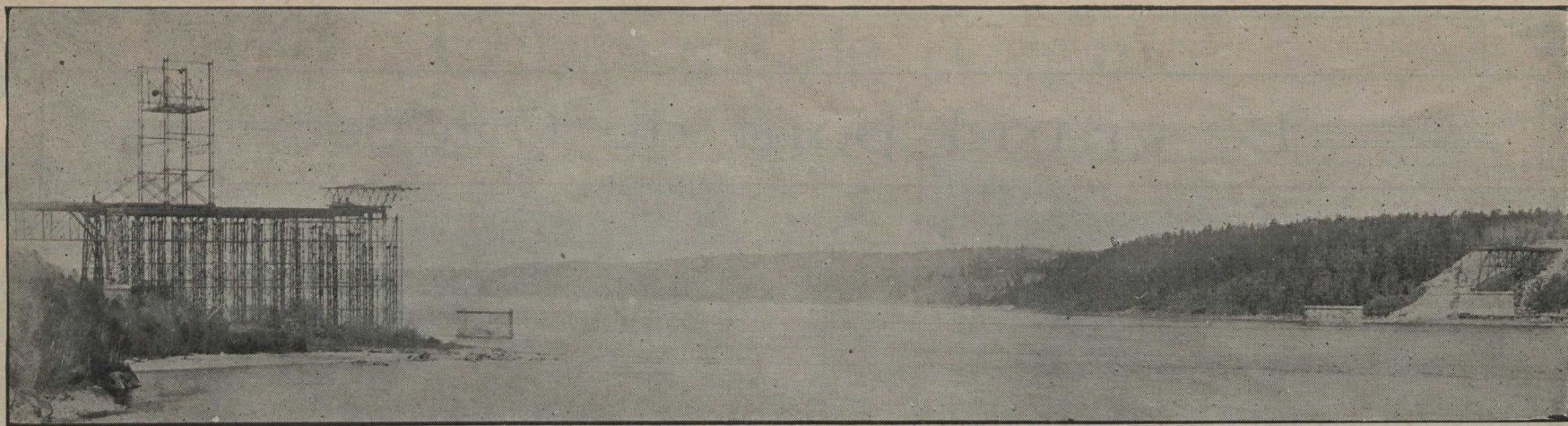
Vue générale des travaux du pont de Québec sur le Saint-Laurent, photographie prise le 7 juin 1905.
