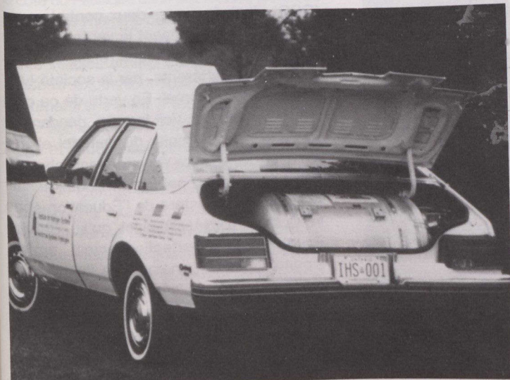
Ce véhicule fait partie des sept autos, dans le monde, qui font l'objet d'expériences de fonctionnement à l'hydrogène.
