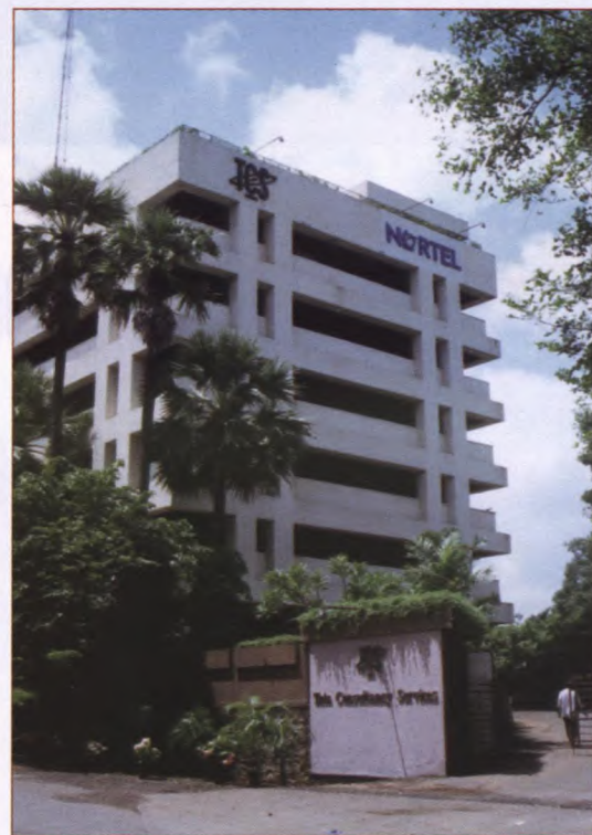
Tata Consultancy Services-Laboratoire de Nortel Networks à Mumbai. Photo reproduite avec l'autorisation de Nortel Networks, à Ottawa
