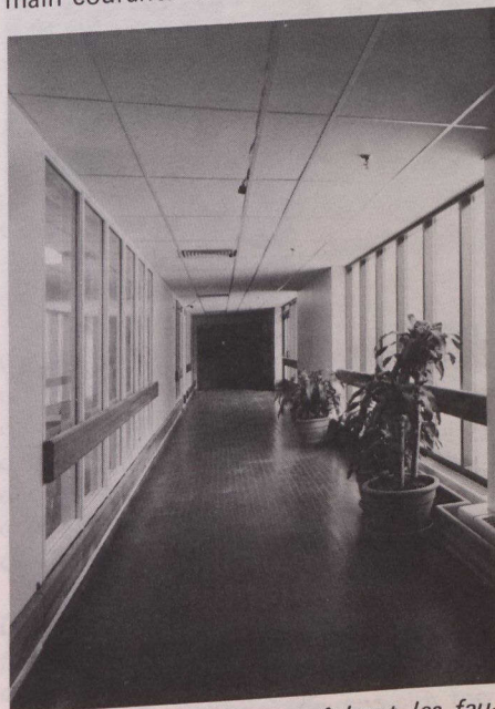
Des butoirs de bois empêchent les fauteuils roulants de heurter le mur.
