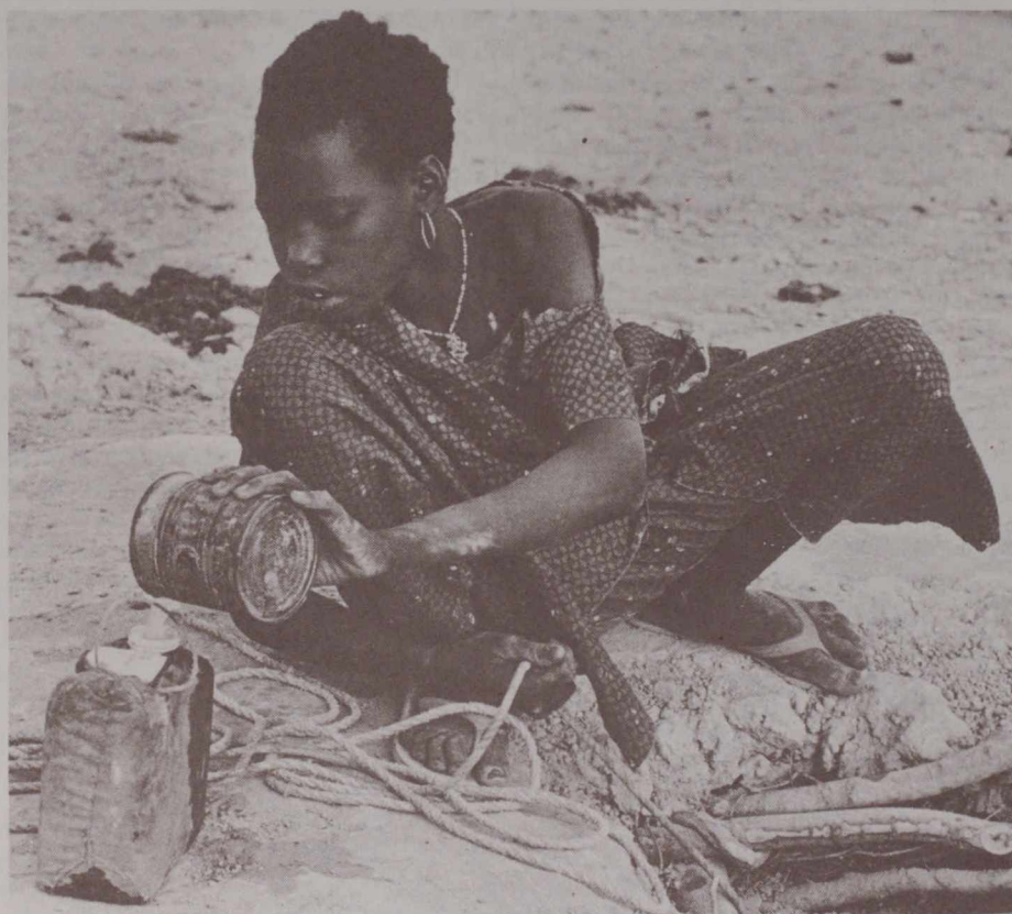
● Avant le forage du puits...
