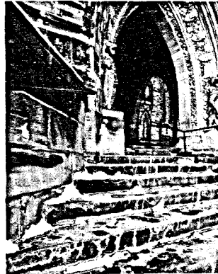
Du sel sur les marches de la tour centrale.
