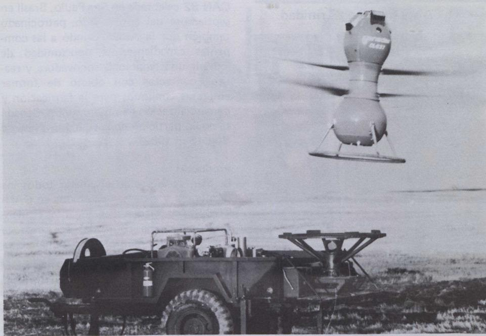
*El vehículo de vigilancia de control remoto CL-227 de la Canadair Limited. La porción superior contiene el sistema motopropulsor y la porción inferior el comando, equipo de control y carga útil. Las hélices contrarrotativas rígidas están montadas en el centro. El CL-227 puede despegar y aterrizar verticalmente, en vuelo horizontal y permanecer en vuelo estacionario.*
