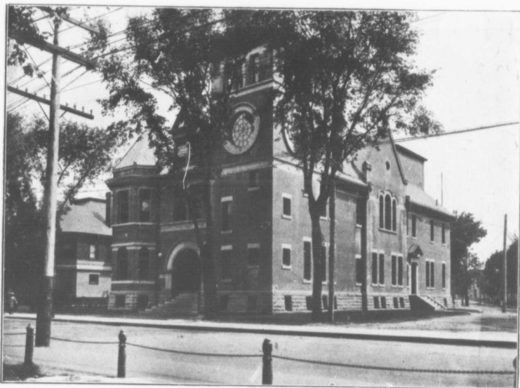
CIVIC BUILDING, TRURO, N. S.
