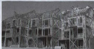
Vue du système de charpente métallique légère à Dalian, en Chine, au début du projet (à gauche), et du produit fini.
