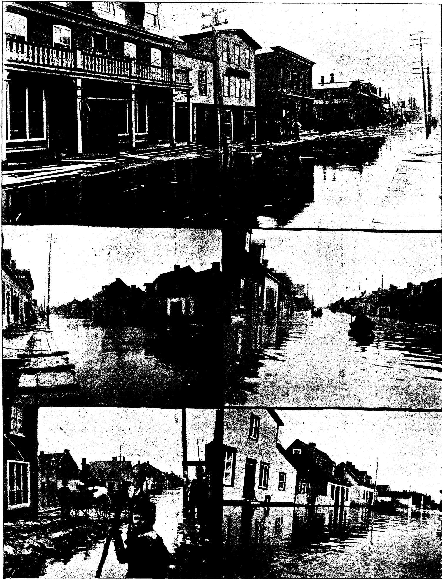
L'INONDATION A RICHMOND, P.Q. : 1. Rue Principale, vue du côté sud. — L'INONDATION AUX TROIS-RIVIÈRES : 2. Rue Saint-Georges, vue de la rue Saint-Olivier ; 3. Rue Saint-Philippe ; 4. Rue Saint-Georges, vue de la rue Notre-Dame ; 5. Rue Saint-Roch—(Photos Pinsonneault)
