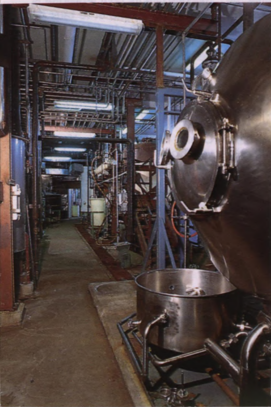
Équipement de fermentation (logen Corporation)
