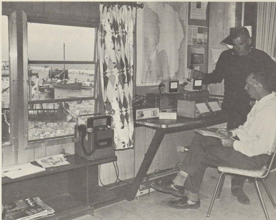
*M. G. W. T. Ashe (assis) et M. Dewar vérifient les données enregistrées par les instruments de contrôle et provenant des appareils de mesure de houle placés sur la plate-forme fixe. Les données sont transmises par télémétrie aux contrôleurs se trouvant au poste côtier du Conseil, à la Station de recherches de l'Institut des Grands Lacs à Baie du Doré.*
