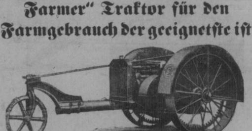
Weil er sehr einfach und gleichmäßig konstruiert ist. 88 Prozent seines Totalgewichtes lasten auf seinen Treibrädern.
