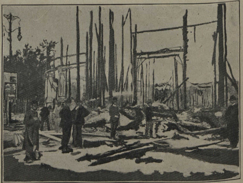
EN ITALIE.—L'incendie partiel de l'Exposition de Milan. La façade du palais des Arts décoratifs, après le sinistre.
