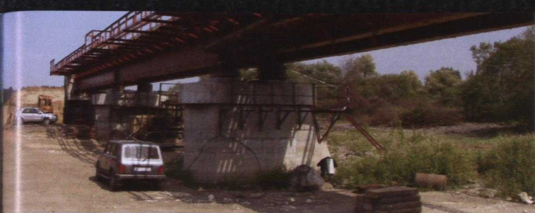
Pont ferroviaire à Shchuch'ye enjambant la rivière Miass entre l'installation de destruction d'armes chimiques et le site de stockage
